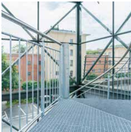
Das dreieckförmige Austrittspodest – ebenfalls mit rutschhemmenden Gitterroststufen belegt.
