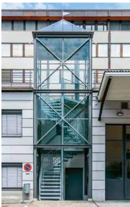
Die alte Treppe im gläsernen Erschliessungsturm wurde durch eine neue Spindeltreppe mit rutschhemmenden Gitterroststufen ersetzt.
